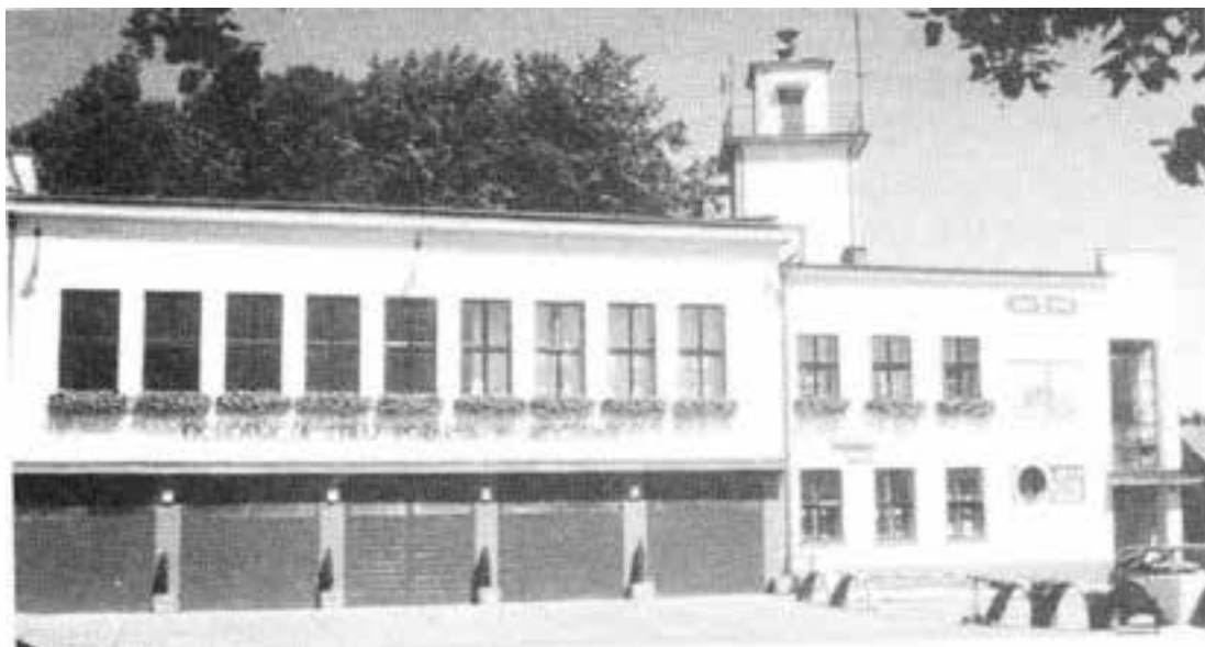
Strażnica OSP z 1939 r. odbudowana w 1945 r.
