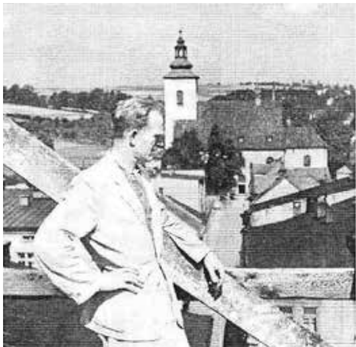
Na dachu ratusza w czasie prac remontowych.
