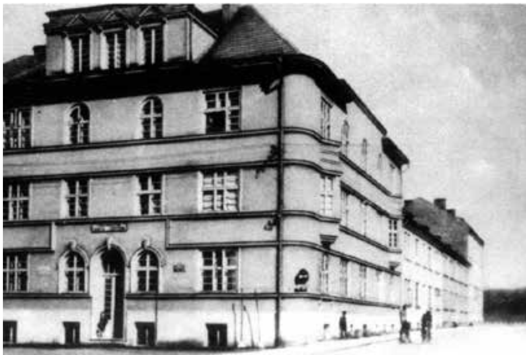
Domy gminne przy ul. Targowej, zbudowane w latach 1927 – 1930.
